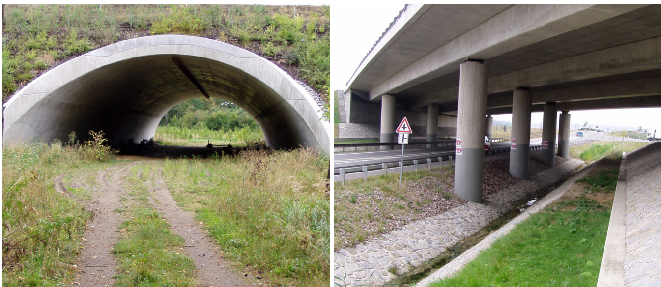
Obr. 7 a 8. Vlevo na fotografii je speciálně navržený migrační objekt na dálnici D11. Vpravo je konvenční most na D11 přes silnici první třídy I/36. Zejména díky vytvoření pásu s přírodním povrchem, je tento most na exitu 36 prokazatelně využíván např. srncem, zajícem nebo liškou. Foto Vlastimil Bogdan
