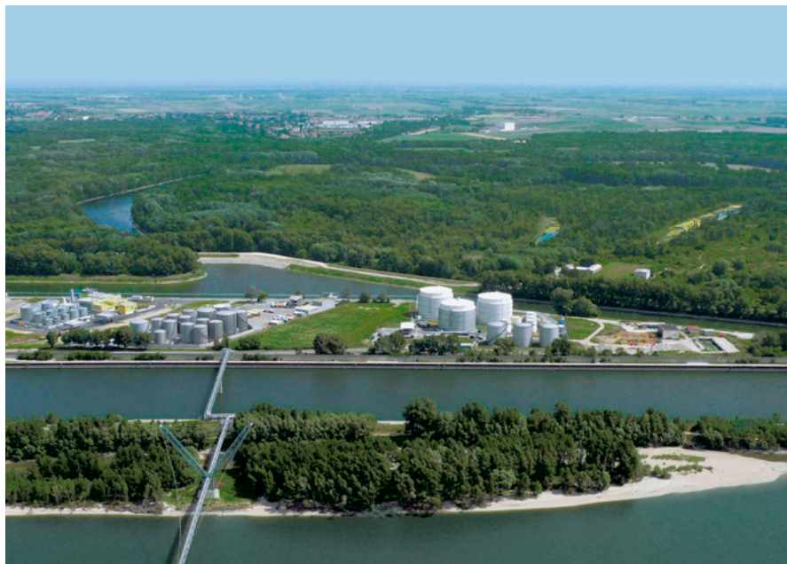
Pohled na část vodního koridoru D-O-L v Lobau ve Vídni, který byl vybudován v 40. letech 20. století. V popředí hlavní koryto Dunaje, za ním nedávno zřízený odlehčovací kanál a dále v pozadí několik kilometrů dlouhý funkční úsek průplavu D-O-L (vpravo) a vyústění do přístavu v Lobau (vlevo). Foto Jaroslav Kubec
