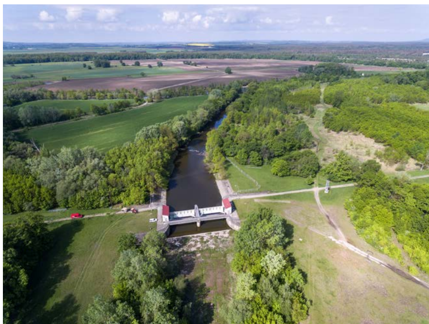
Odlehčovací jez Pohansko reguluje průtoky do poldru během extrémních povodní, také ale umožňuje přivést vodu do poldru v době, kdy ji les potřebuje, respektive kdy mu umožní doplnit důležité zásoby vody v půdě nebo nasycit spodní vody. Foto archiv autora
