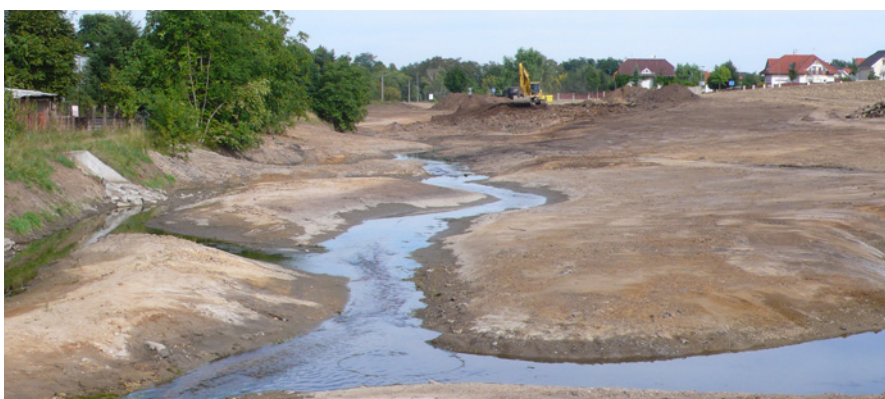
Jako poslední probíhala výstavba středního úseku revitalizace pod náměstím v Hostivicích. Rozsáhlé těžení zemin umožnilo zásadně změnit charakter potočního perimetru a vytvořit „vodní krajinu“, jakou by tu dříve nikdo nečekal. Foto Tomáš Just
