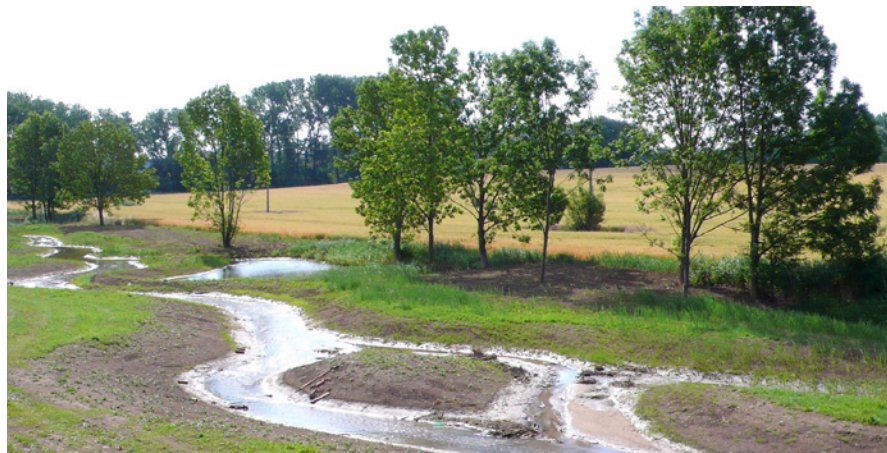
Výstavba dolního úseku revitalizace pod ČOV. V prostoru dřívějšího technicky upraveného koryta – procházelo podél řady stromů vzadu – byl vyhlouben sled biotopních tůň. Většina z nich byla v zájmu ochrany obojživelníků následně oddělena od kynety kamennými záhozy, omezujícími vstup ryb z potoka.. Foto Tomáš Just
