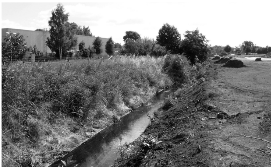
Litovický potok v Hostivicích při zahajování prací. Produktem starší technické úpravy byla přímá trasa, lichoběžníkový průřez, opevnění dlažbou, minimální tvarová a hydraulická členitost, většinou výrazné zahloubení proti okolnímu terénu. Foto Tomáš Just
