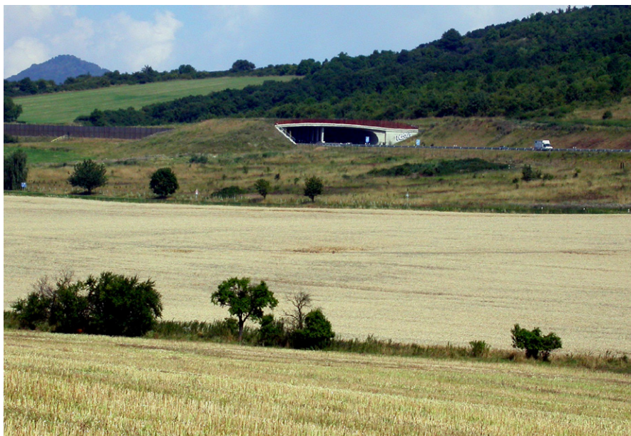
Obr. 3. Ekodukt na předchozím úseku dálnice D 8 u Blínky před Vchynickým mostem. Relativně prudký svah jihozápadního předmostí by pravděpodobně nebyl překážkou pro medvěda, pokud by ovšem ekodukt nestál uprostřed Českého středohoří. Ekodukt nemohl být delší – ústí přímo do křižovatky staré silnice I/8 a odbočky do Vchynic... Bude zajímavé sledovat, jakými druhy bude využíván. Foto Archiv Děti Země
