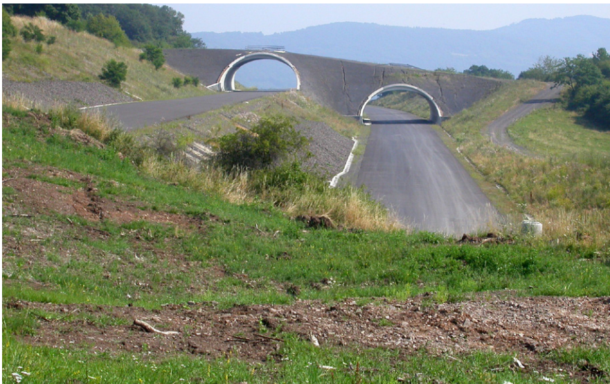
Obr. 2. Ekodukt na dálnici D8 u Prackovic ve fázi výstavby. Fotografováno z dnes již odtěženého sesuvu, který v roce 2013 zavalil nedokončenou dálnici. Umístění ekoduktu z hlediska konfigurace terénu je dobré, na první pohled je však zjevné, že ekodukt je příliš úzký a negativní vliv dálnice nebude možné plně odstínit. Navíc je vzdálen pouhých 640 m od Prackovické estakády, která umožňuje podejít dálnici D 8 jakýmkoli druhům živočichů. Tento úsek by však teoreticky mohl být v budoucnu vhodný pro realizaci krajinného koridoru, táhnoucího se až k Prackovické estakádě; její náklady by pravděpodobně nebyly o mnoho vyšší než asanace sesuvu a dosud neukončená stabilizace estakády... Foto Archiv Děti Země.
