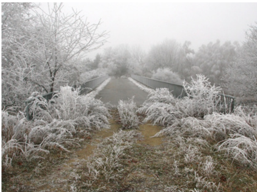
Nad D1 se tyčí i mosty, které jsou minimálně využívány lidmi a mohou dobře sloužit jako migrační objekt. Tímto v zásadě projíždí pouze lesnická technika. Foto Petr Suvorov
