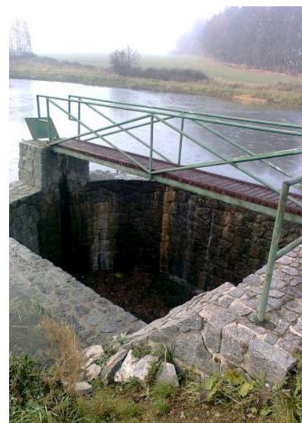
Na Brtnickém potoce se nacházejí dva rybníky oddělené dálnicí. Vyskytují se zde vydry. Na jedné straně potkají hezký dvojitý betonový propustek, který ovšem na druhé straně ústí do výpusti rybníka šachtovitěho typu o výšce cca 2,5 m. Tomu se říká dead end. Foto Marie Brůčkové.
