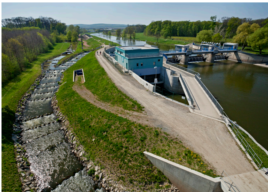
Rybí přechod u MVE na jezu Bulhary. Zdroj: Cech malých vodních elektráren.
