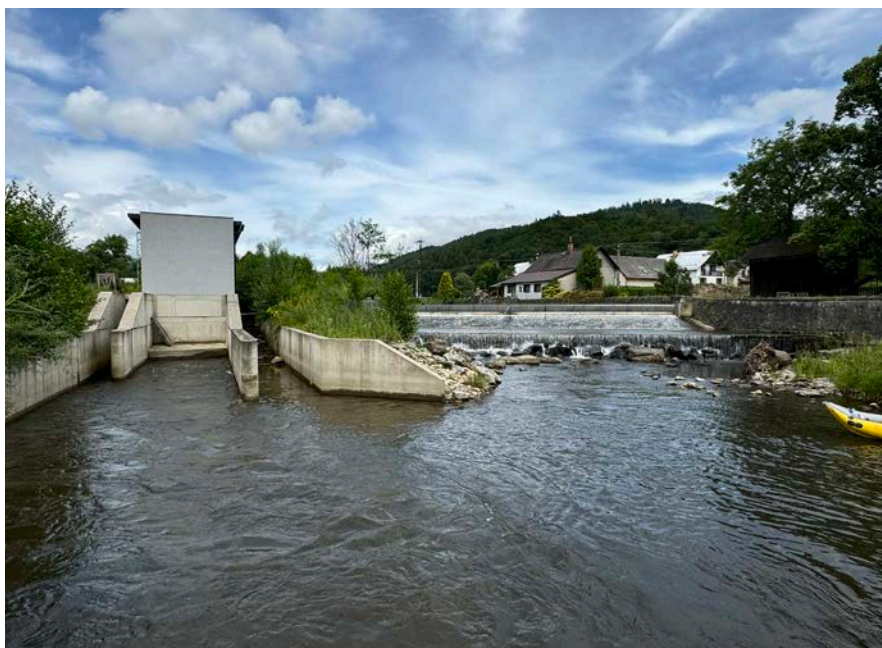
Ukázka velmi nevhodné rekonstrukce jezu s výstavbou MVE – nefunkční pro migraci i pro vodáky (Bohdíkov, řeka Morava). Foto Jan Hradecký
