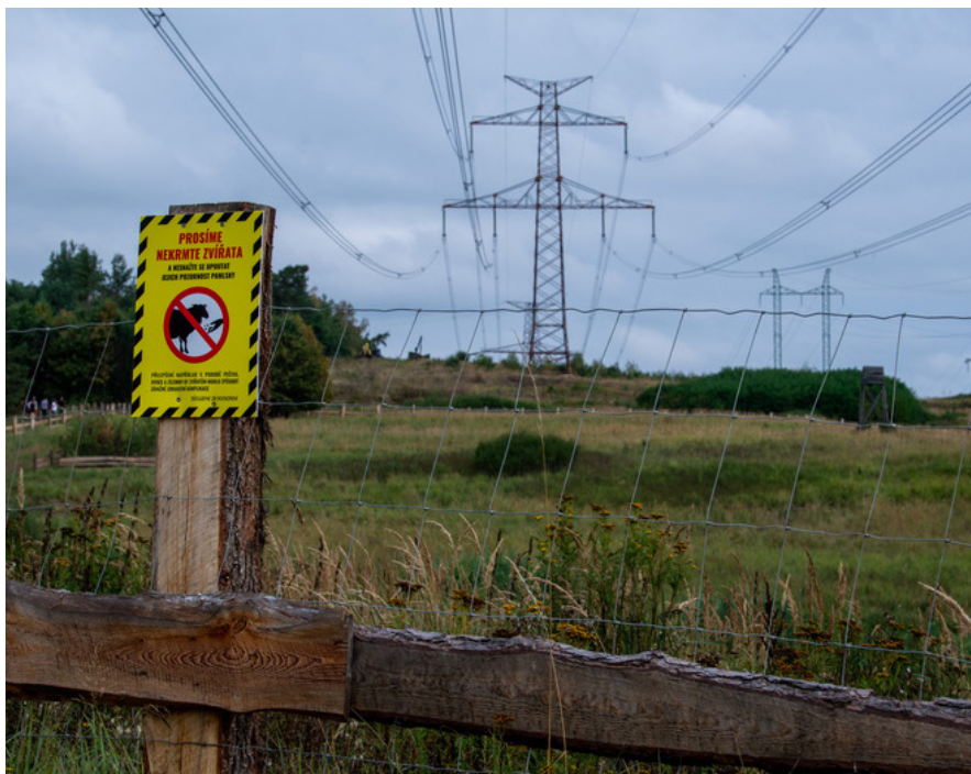
Údržba ochranného pásma vedení přenosové soustavy využitím spásáním trávy ovce u Drhovle, 20. srpna 2024. Foto ČKT/Václav Pancer.
