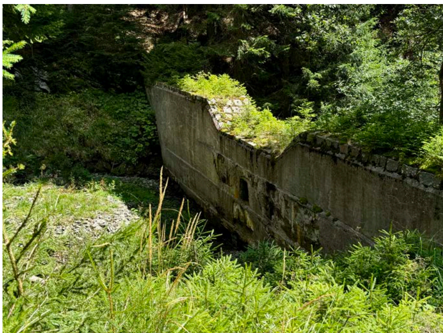
Objekt rozpadající se přehrázky stále představuje výraznou bariéru na toku (Hrubý Jeseník). Foto Jan Hradecký
