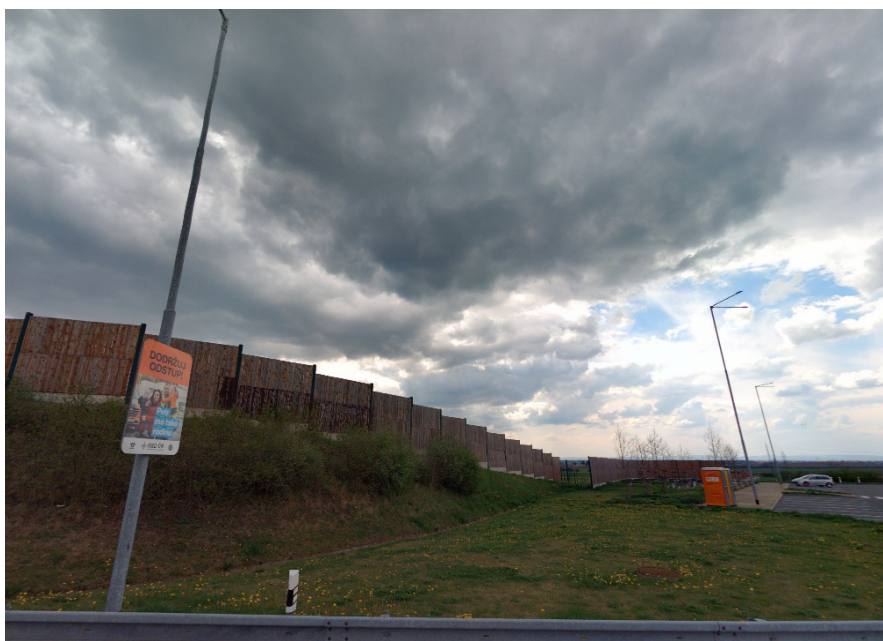
V rámci dálniční odpočívky Osice na dálnici D11 byla osazena stěna z důvodu ochrany před rušivým osvětlením sousední lokality. Zdroj Mapy.cz
