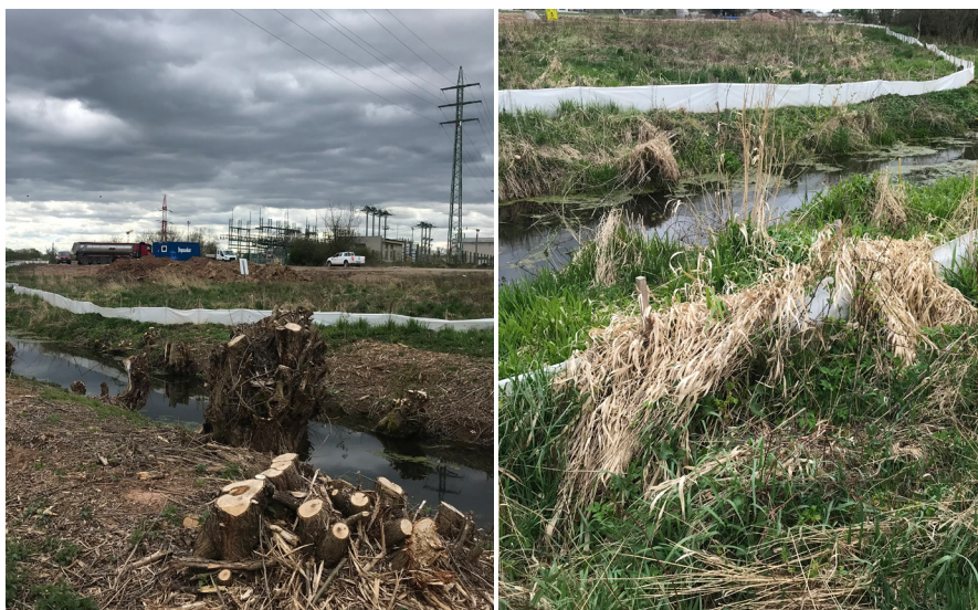
Například na lokalitách, kde stavba silnice představuje riziko negativních vlivů na obojživelníky, bývají instalovány dočasné bariéry, které mají zabránit živočichům vstoupit do nebezpečného prostoru stavby. Na obrázku jsou bariéry instalované na stavbě přeložky silnice I/36 v Pardubicích. Zdroj ŘSD
