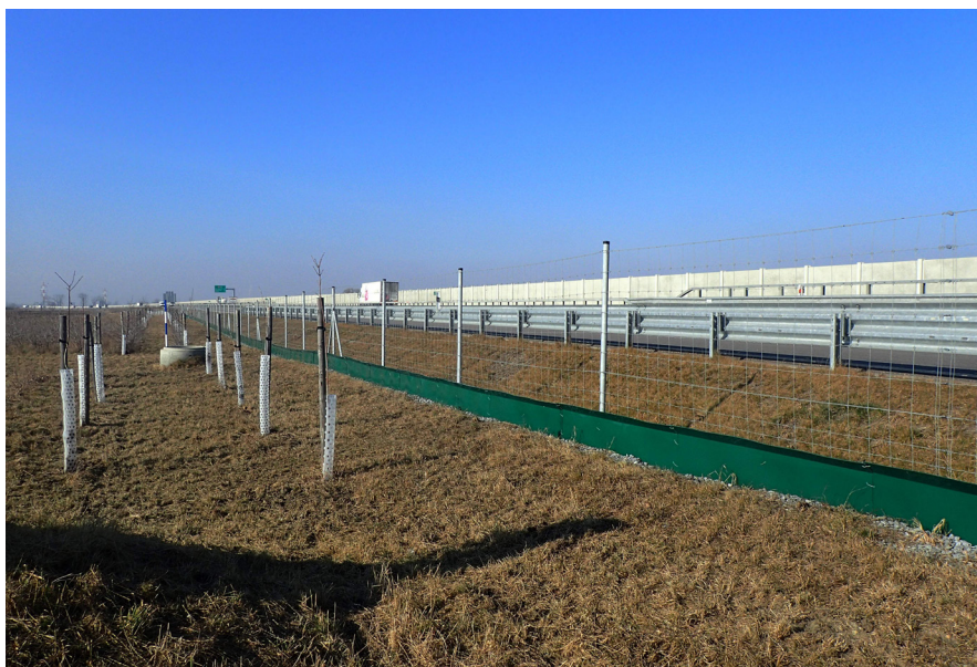
Oplocení dálnice včetně trvalé naváděcí bariéry pro obojživelníky. Oplocení dálnice je doplněno výsadbou izolační zeleně, která se v budoucnu stane pohledovou bariérou. Zdroj ŘSD
