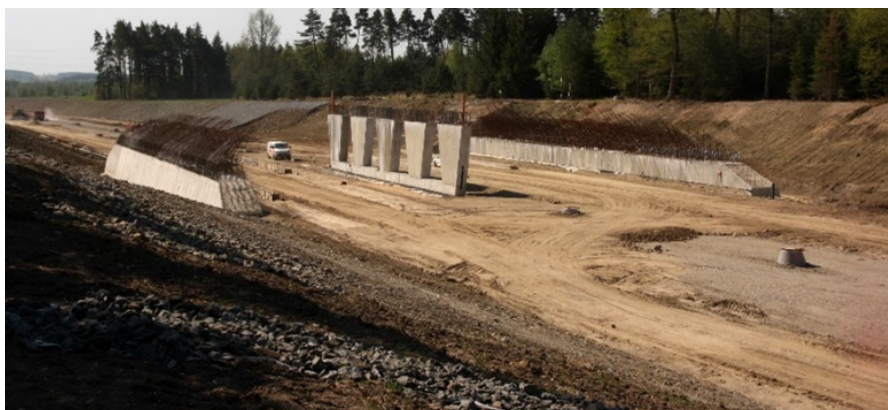
Stavba ekoduktu na dálnici D3 v úseku Veselí nad Lužnicí – Tábor. Kdo by dnes zpochybnil zkrácení a zlevnění cesty z Budějovic do Prahy, byť je cestování poněkud nudnější? Chceme snad jezdit jako před dvěma sty lety dostavňákem, s noclehem v Dobříši a s průjezdem Brdských lesů plným loupežníků?
